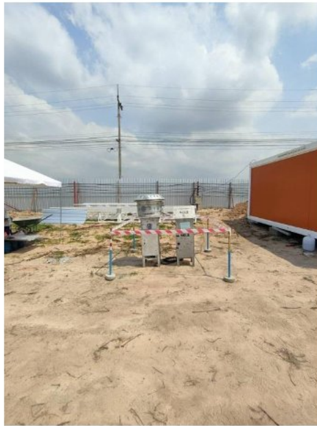
รูปที่ 1 บริเวณพื้นที่โครงการ
